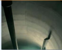
Profil de surface de 75 µm obtenu par sablage et propreté de surface SA 3
